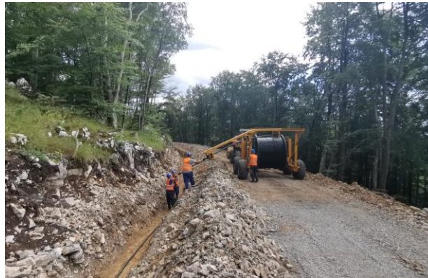
Stroj za polaganje kabela
